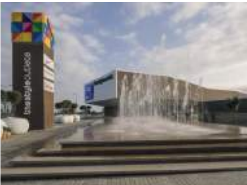
Centro Comercial Viladecans Style Outlet
