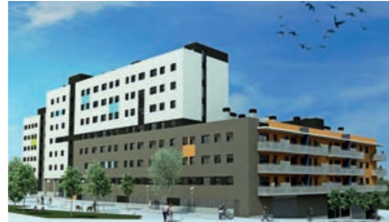
EDIFICI BADALONA STADIUM - BADALONA
